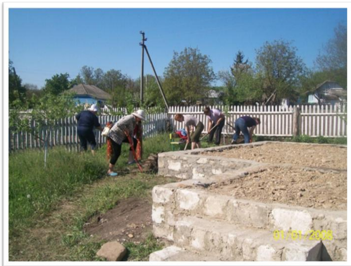
На фото: ДНЗ «Розумашки». Будівництво оздоровчо-ігрового центру
